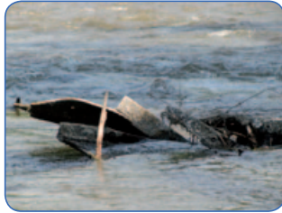
Niebezpieczny element starego mostu kolejowego w Dorohusku, fot. Józef Tworek
