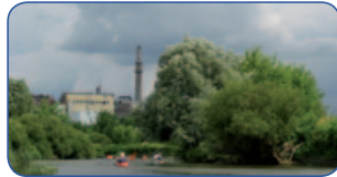
Budynki cukrowni w Strzyżowie, fot. Józef Tworek
