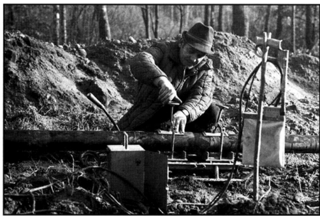
Fot 2. Prototypowa zgrzewarka ręczna IG.
