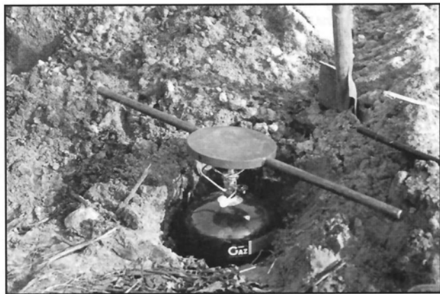
Fot 3. Płyta stalowa podgrzewana gazem płynnym.
